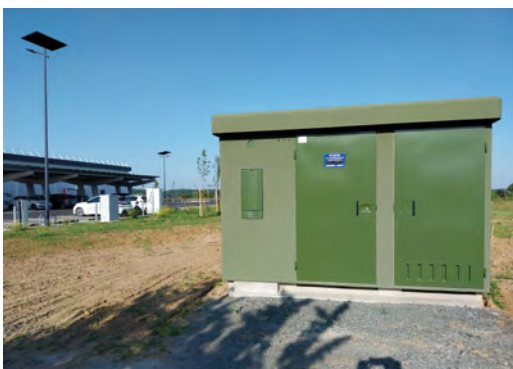
Installation d'un nouveau poste de transformation à Château-Renault.
